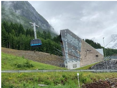
...Loen Skyliift Bodenstation
